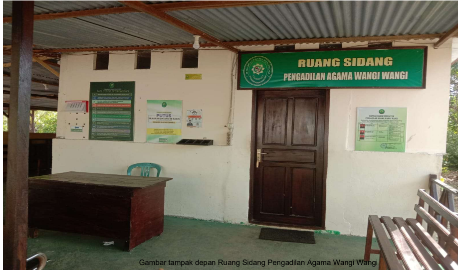
Gambar tampak depan Ruang Sidang Pengadilan Agama Wangi Wangi
